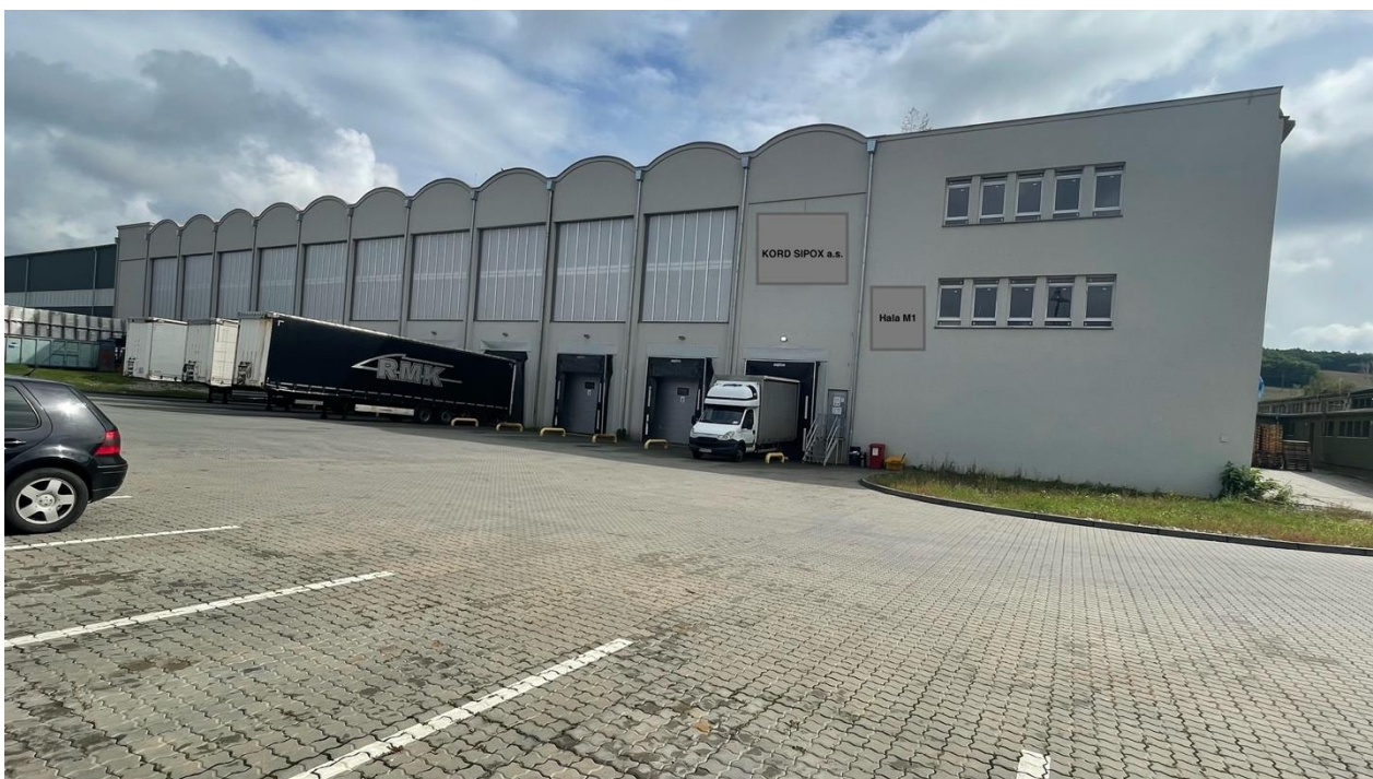
Hala a vonkajšie spevnené plochy
